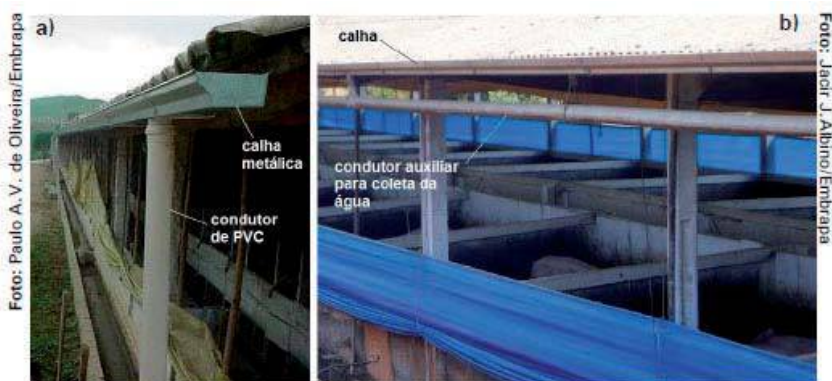
FIGURA 3 - ESQUEMA DE SISTEMA DE CAPTAÇÃO. Fonte: EMBRAPA
